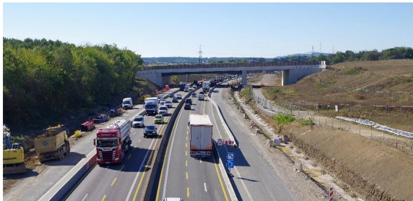
Rechts: Die neue Grünbrücke mit differenzierter Bepflanzung
