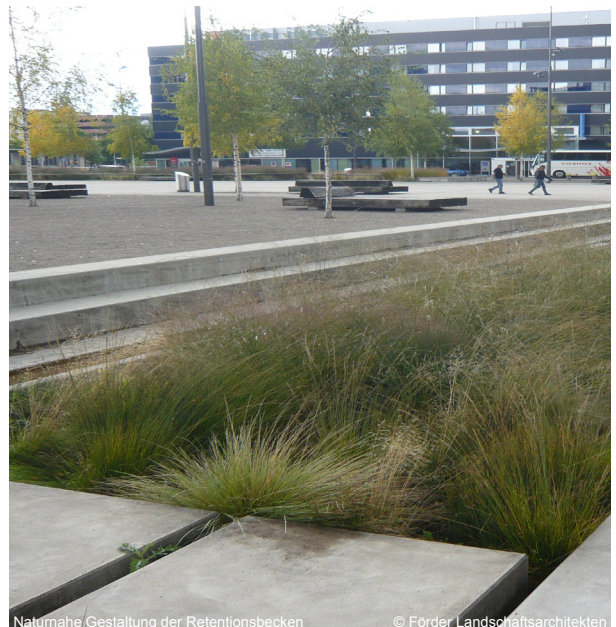
Naturnahe Gestaltung der Retentionsbecken
